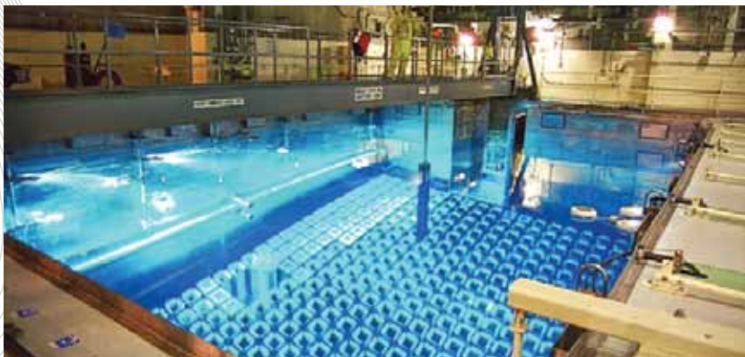
1 pav. Saugykloje po vandeniu saugomos panaudoto kuro rinklės
