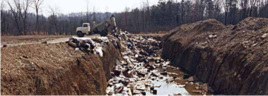
1 pav. Branduolinės eros pradžioje radioaktyviosios atliekos buvo laidojamos tiesiogine prasme – užkasamos žemėje
