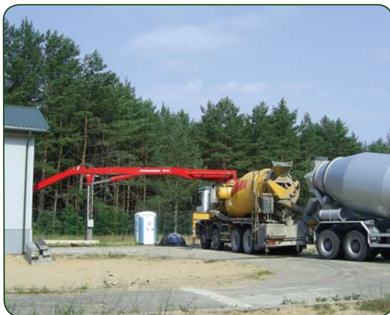
Vyksta dezaktyvacijos kameros betonavimo
